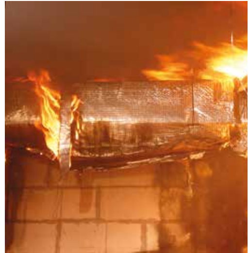
Fig. 17 - El conducto en chapa muestra una importante participación en la difusión del incendio
