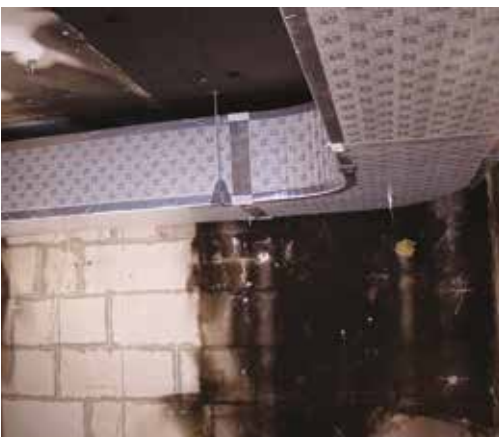
Fig. 11 - Instalación del conducto en aluminio pre-aislado P3ductal
