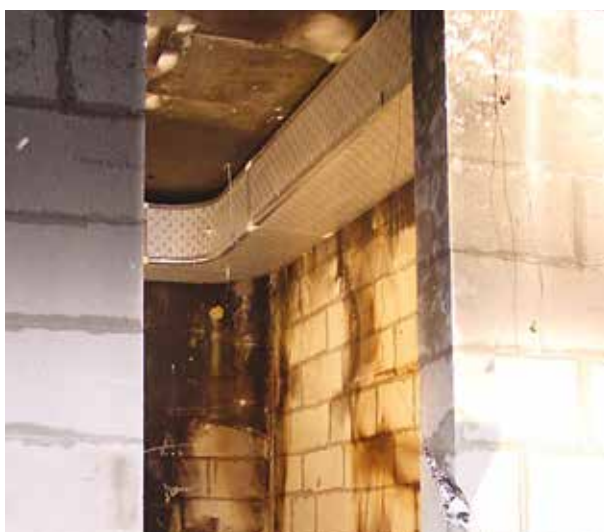
Fig. 8 - La conformación de la sala para el Room Corner Test
